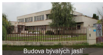
Budova bývalých jaslí
