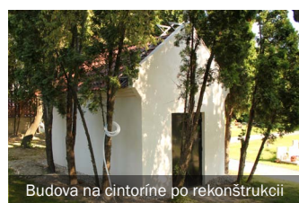
Budova na cintoríne po rekonštrukcii
